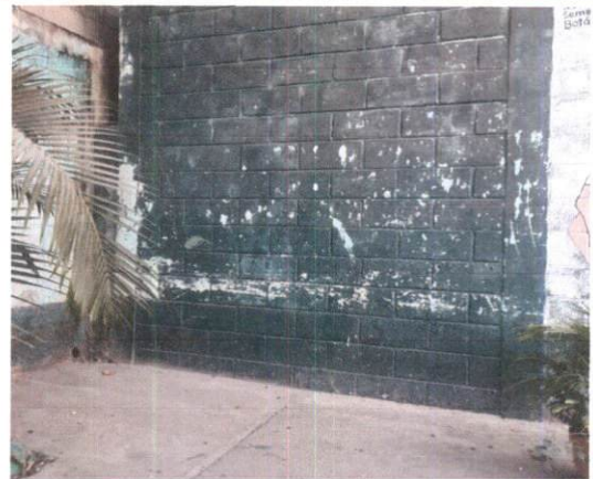
Foto 4: Mejoramiento de pintura
