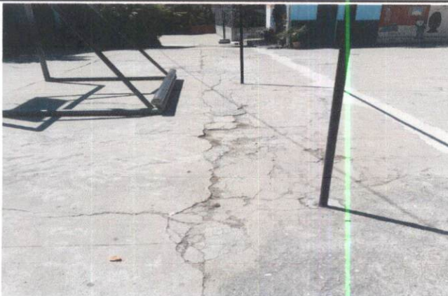
Foto 3: Mejoramiento de losa de patio
